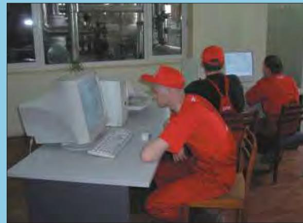
Созданная АСУ ТП является масштабируемой, поэтому в перспективе система может быть расширена дополнительными автоматизированными рабочими местами операторов, а также рабочими местами без функции управления, работающими в режиме "только просмотр" (для административного персонала котельной).
