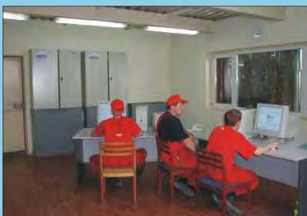
Автоматизированные рабочие места оператора и инженера котельной, шкафы контроллеров
